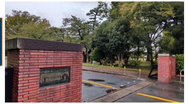
新施設に建て替え中の 都立瑞江葬儀所(江戸川区)
